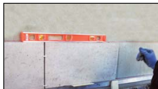
El uso de un canal rígido de aluminio puede ayudarlo a soportar y nivelar la primera fila de losetas durante la colocación.
