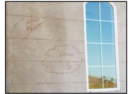
Marque todas las áreas bajas y use la mezcla cemento-cola para nivelarlas a la altura adecuada antes de colocar la loseta de la serie Classic Series.
