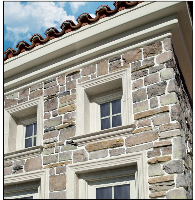
Cepillado completo y lechada color blanco
