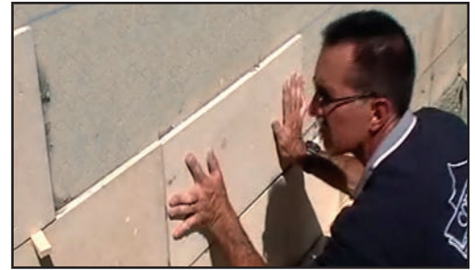
Coloque la loseta en la pared usando un movimiento de izquierda a derecha.
