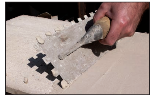
Aplique una capa de mortero modificado con polímeros en la parte posterior de la piedra.
