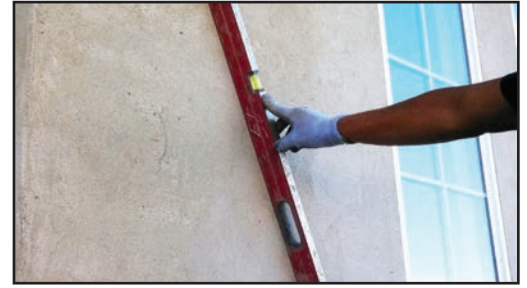
Utilice un nivel largo o una regla para confirmar que la pared esté plana.
