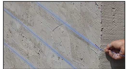
Trace líneas de tiza cada 4 a 8 pulgadas.
