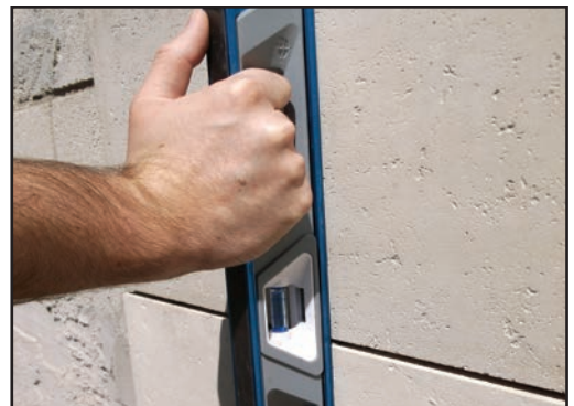
Use un nivel grande para verificar y mantener un plano de cara uniforme sobre distintas losetas.
