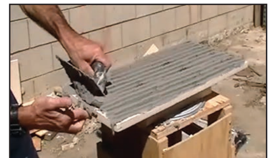
Use una llana dentada de 1/2 in (1.27 cm) para aplicar un mortero modificado con polímeros que no se deforme en la parte posterior de la piedra.
